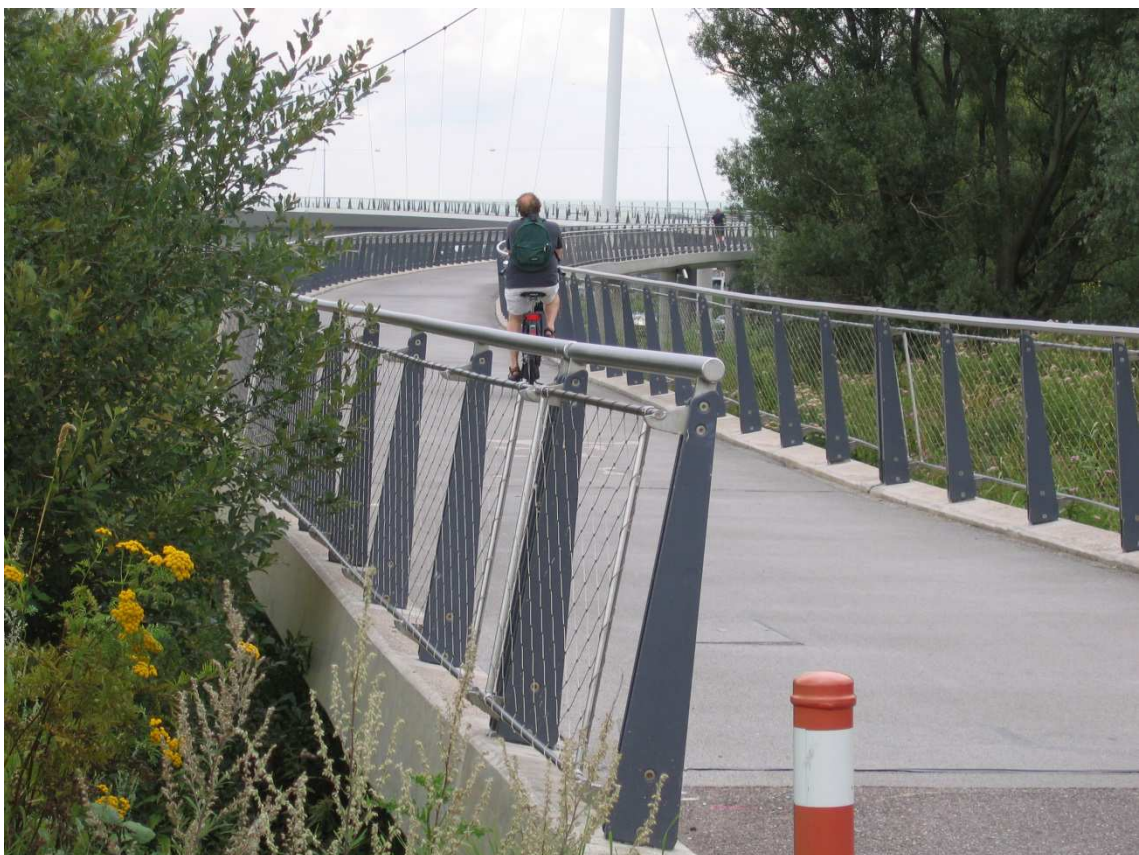
Fietsbrug over Amsterdam-Rijnkanaal verbindt IJburg met bestaande routenetwerk
